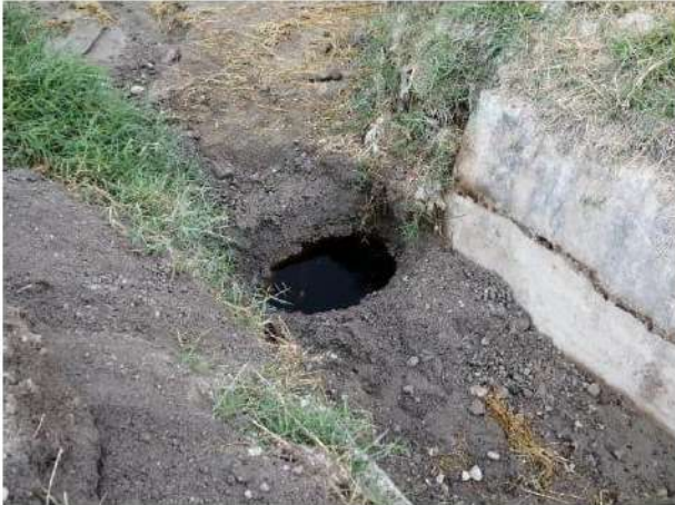
La parte extrema hacia el Este
